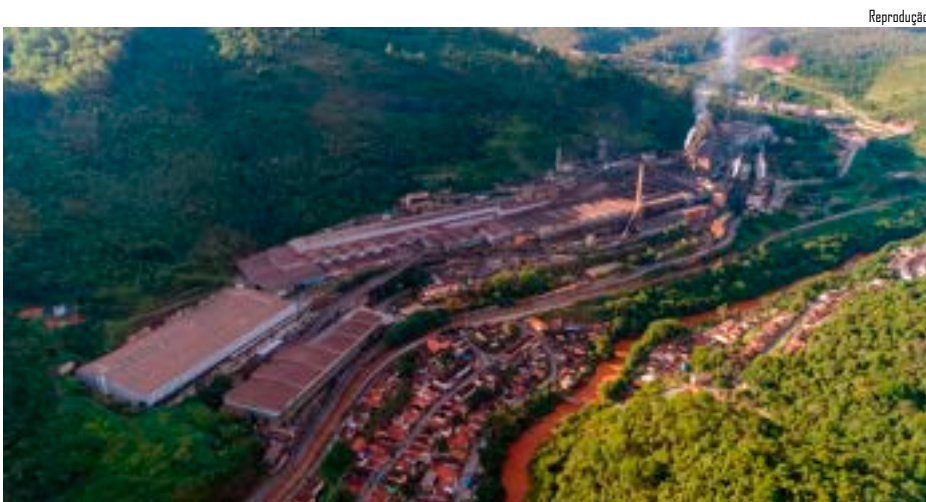
Vista área da Usina de Monlevade
